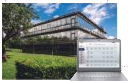
Sistema de gestão de edifícios (BMS)
